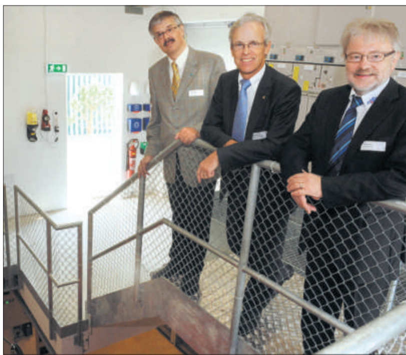
Gemeindepräsident Ruedi Amrein (von links), Regierungsrat Max Pfister und Franz Hodel, Geschäftsführer Steiner Energie, begutachten das neue Wasserkraftwerk.
