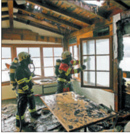
Zwei Feuerwehrleute bei den Löscharbeiten.
