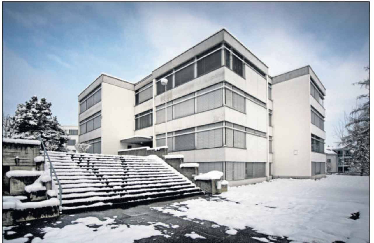
Die Schulanlage Hübeli in Emmen wird während der nächsten Sommerferien umfassend saniert.
